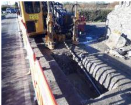
Príomhphíopa nua uisce a shuiteáil san Achadh Úr (obair á déanamh faoin gClár Líonra Uisce)
