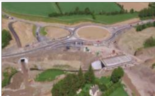
Oibreacha Tógála ag Timpeallán an Ghleanna Mhóir agus íosbhealach an bhóthair
