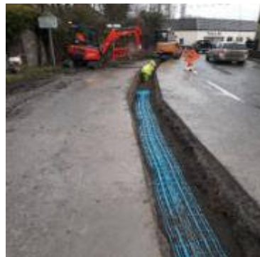
Suiteáil de phríomhphíopa uisce nua le Druileáil Threorach san Achadh Úr
